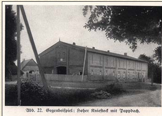
Abb.22 Gegenbeispiel: Hoher Kniestock mit Pappdach. (Abb. nach Seite 122, unpag.)
