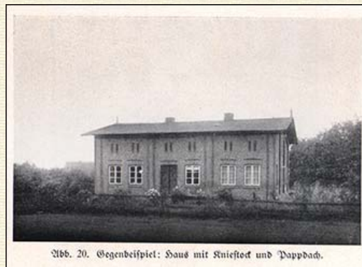
Abb.20 Gegenbeispiel: Haus mit Kniestock und Pappdach. (Abb. nach Seite 122, unpag.)
