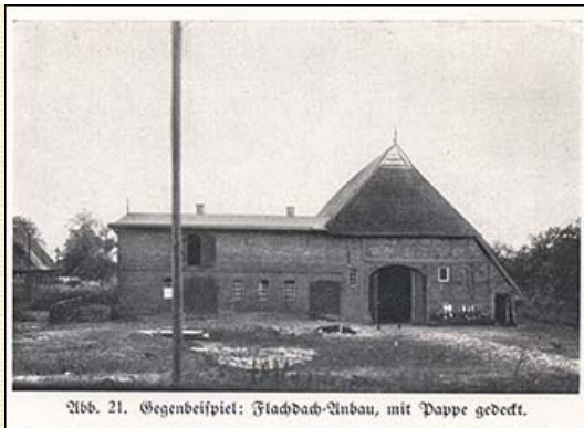
Abb. 21 Gegenbeispiel: Flachdach-Anbau, mit Pappe gedeckt. (Abb. nach Seite 122, unpag.)
